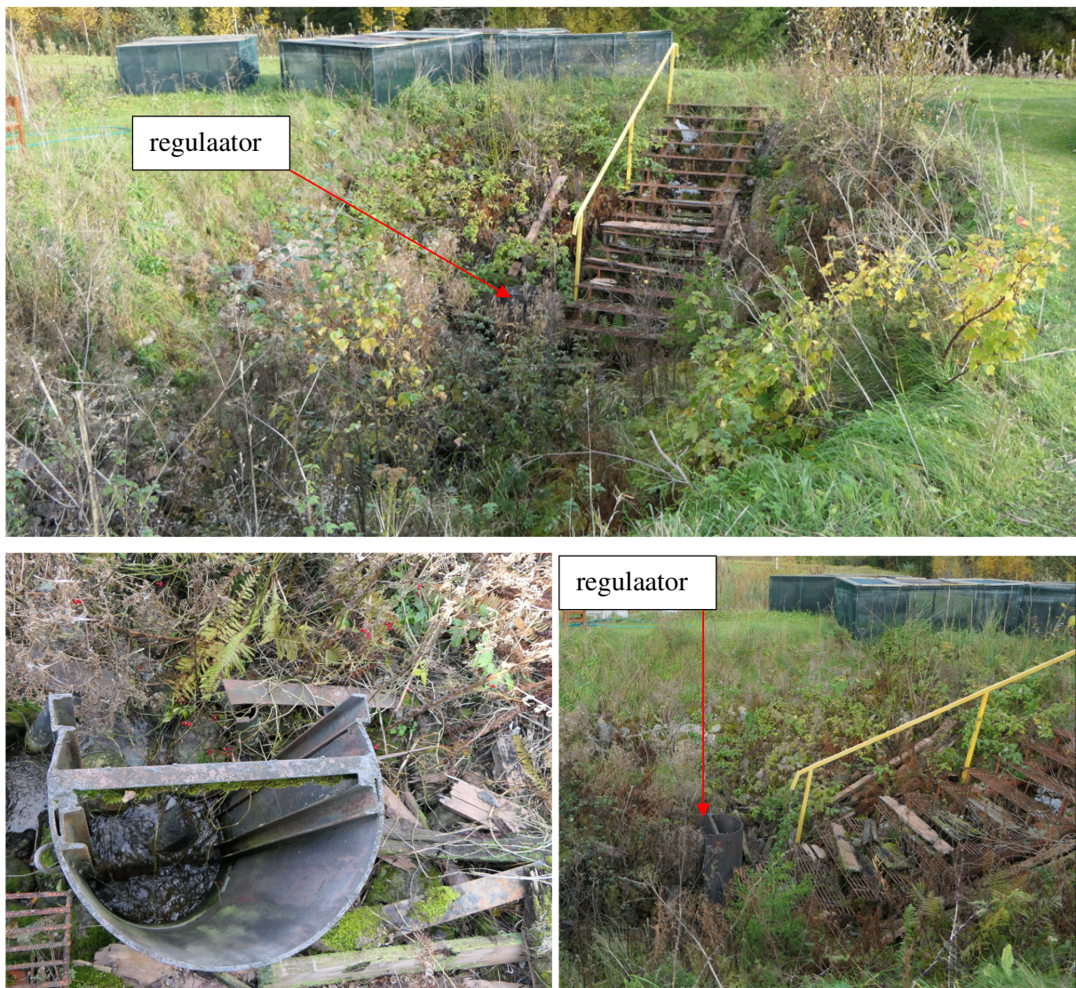
Foto 1. Ühendustiigis paiknev regulaator ja teenindustrepp
