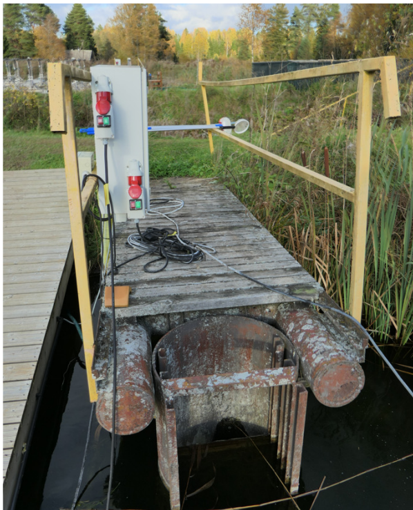
Foto 2. Lõunapoolses kasvandustiigis paiknev regulaator
